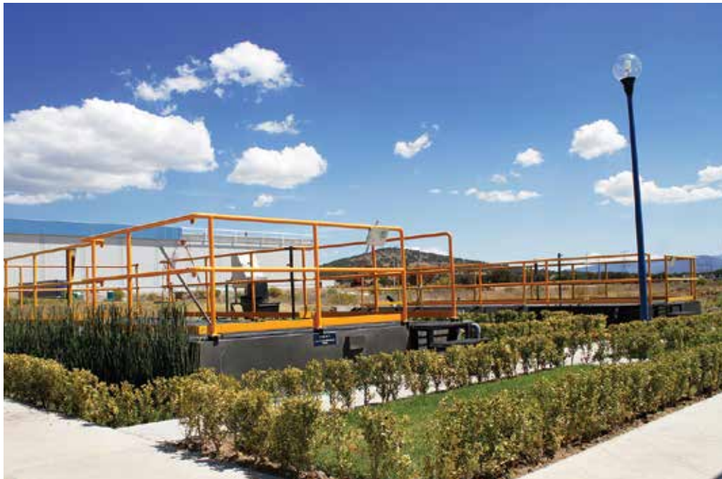
Planta de tratamiento de agua en Planta Tlaxcala
