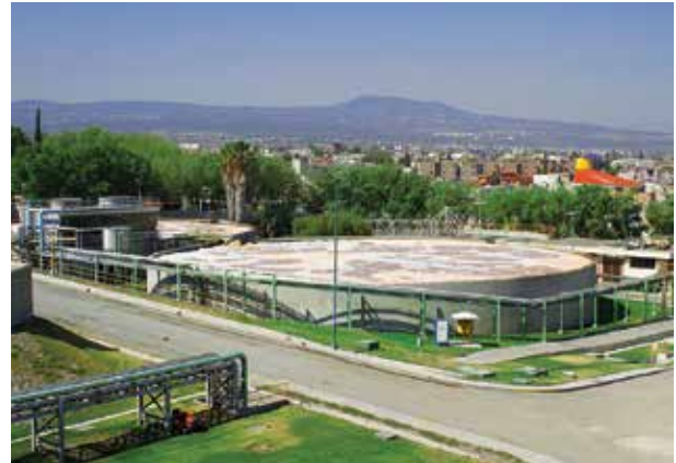
Planta de tratamiento de agua en Planta Bajío
