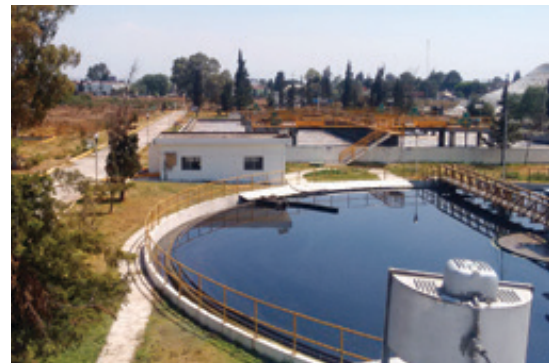
Sistema de tratamiento de agua de post-consumo
